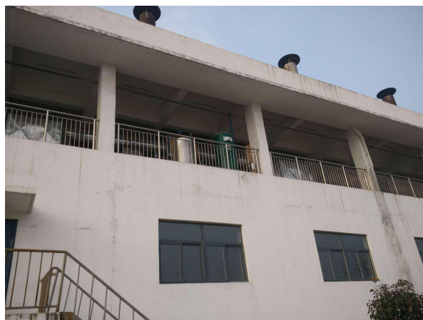
260 试车废气排气筒
