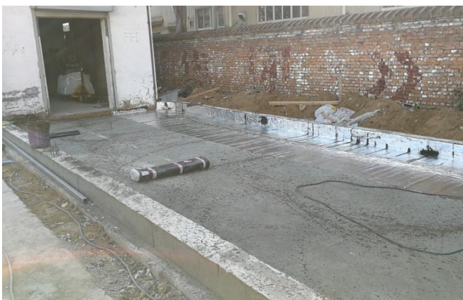
防渗施工照片
